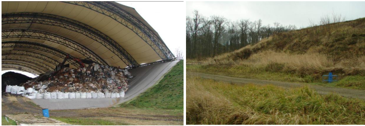
3. ábra. Az aszódi veszélyeshulladék-lerakó feltöltés alatt lévő depóniája, melyre termőréteg kerül, és végül a jobb oldali képen a teljesen rekultivált tárolómedence látható
