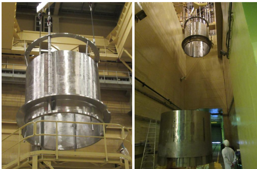
1. ábra. A munkaplatform felső része, és a felső rész ráhelyezése az alsó részre
