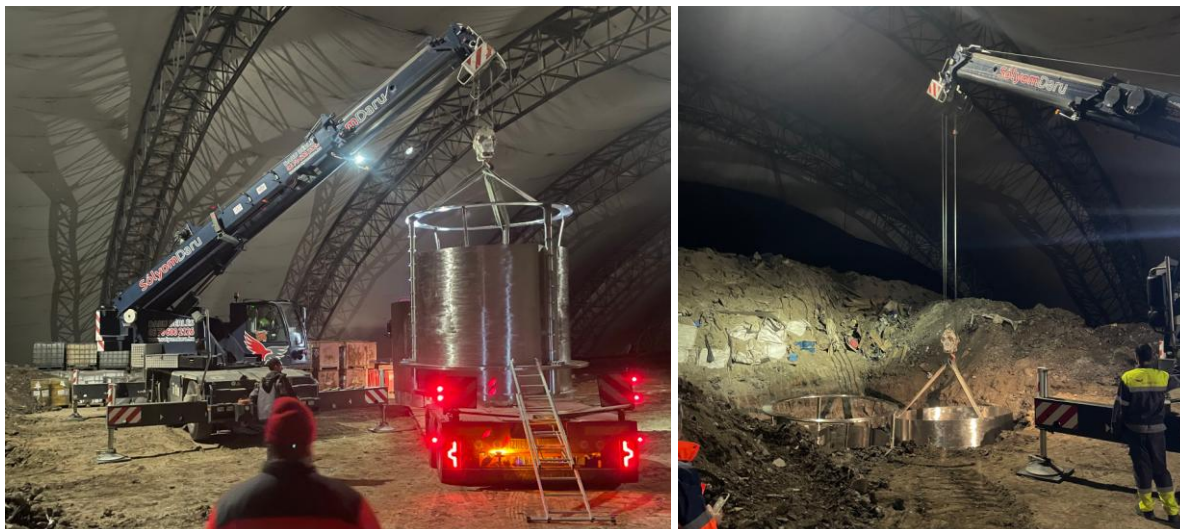
5. ábra. A platform leemelése a szállítójárműről a depónia térben és elhelyezése a hulladéktestben számára előzetesen kialakított gödörben
