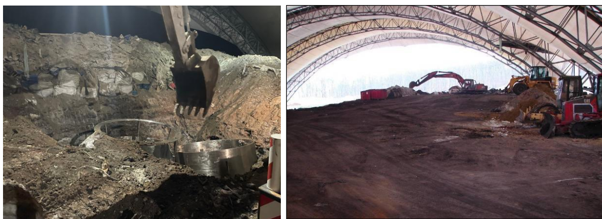
6. ábra. A fedőréteg elhelyezése az aszódi lerakó tárolómedencéjében, majd a lefedett és stabilizált munkaterület
