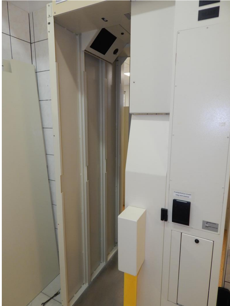
Sugárkapu hátfal ólomárnyékolás nélkül
